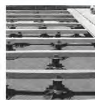
Govalift 5 types pour plusieurs hauteurs Le Govalift doit supporter les piquets eco chaque 35 cm Usage per m 2 : 6,5 pcs.
