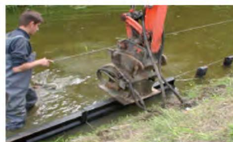
2. Placer les panneaux derrière les pieux et les assembler à rainure et languette. Ensuite les tapoter ou les enfoncer de manière que le dessous du bord supérieur du panneau repose sur le pieu.
