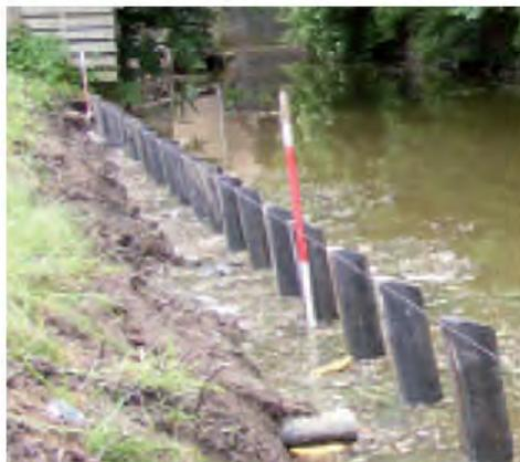
1. Tirer le fil pour l'alignement et enfoncer les pieux chaque 0.70 m (centre - centre). Outil disponible pour faciliter l'enfoncement et protéger le pieu. La longueur nécessaire du pieu dépend de la condition du terrain. Eventuellement ancrer dans le talus.
